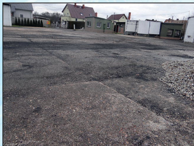
duża część placu posiada betonowe podłoże
