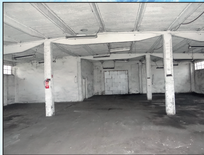
wnętrze hali murowanej 440 m 2
